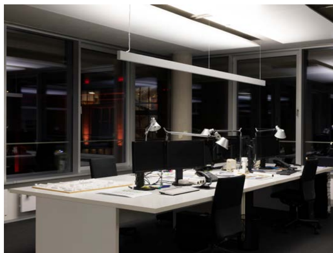
Abb.: An den Arbeitsplätzen wählte man die LED-Pendelleuchte »Linargo« mit einer getrennt schaltbaren Direkt-/Indirektbeleuchtung.
