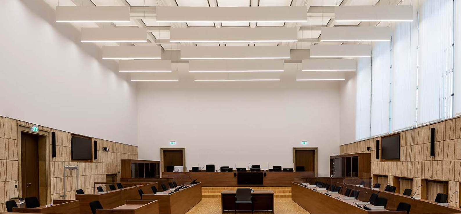
Abb.: Die Pendelbaffleleuchten nehmen die Struktur der Decke auf. Das Farbkonzept der Decke konnte übernommen werden, da das Aluminiumgehäuse mit einer Pulverbeschichtung in der RAL-Farbe der Decke versehen wurde.
